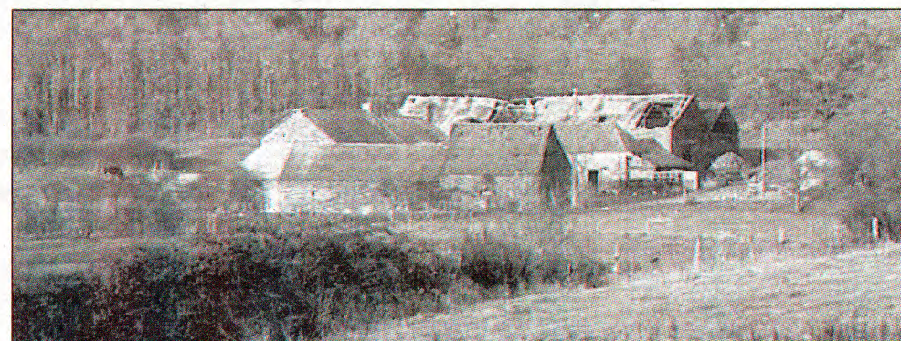
Vue d'ensemble des bâtiments de ferme avant l'acquisition par Comblessac et Guer.
